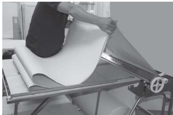
Bij werken met de machinetafel vouwt u het ingesmeerde behang in de tafellengte samen.
