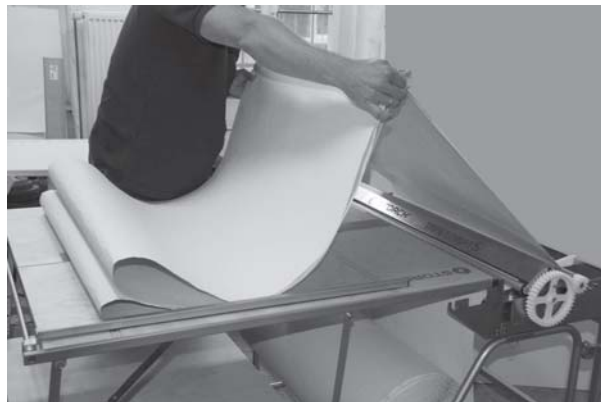
Při práci se stolem stroje skládejte tapetu na délku odpovídající délce stolu.
